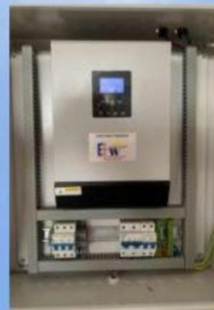
Командна кутија со хибриден инвертор 3kW и 60A Контролери
